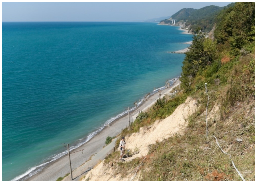
Рисунок 2 – Контроль оползнеопасного склона пос. Головинка (Краснодарский край)
