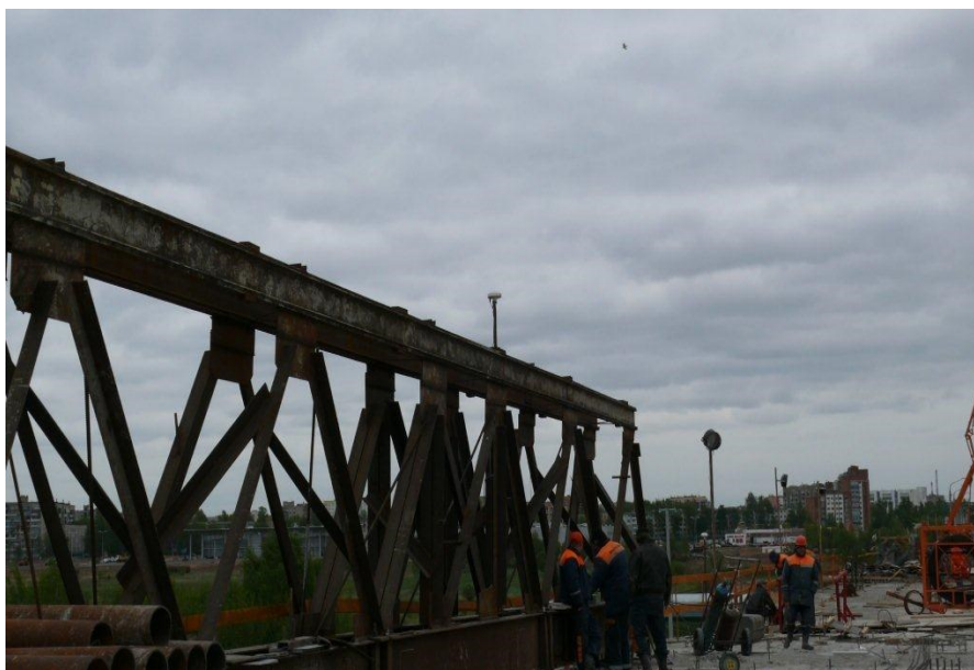
Рисунок 4 – Контроль моста во время ремонта г. Могилев (Беларусь)
